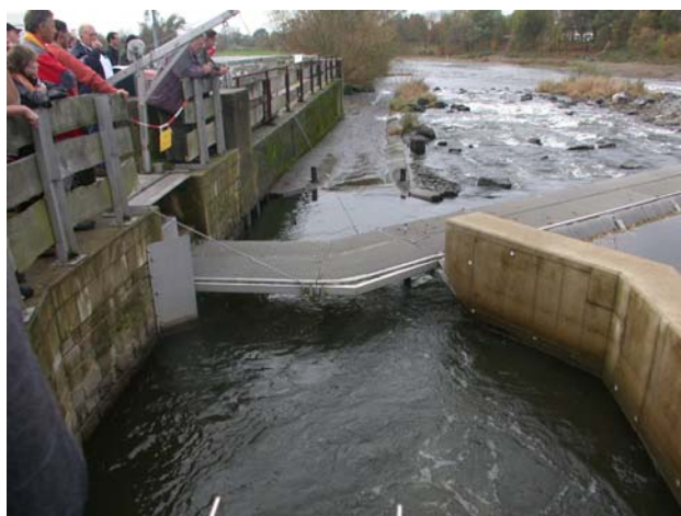
Figure 18 : Rampe en enrochements au seuil de Buisdorf sur la Sieg
