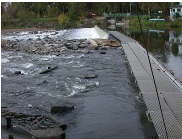
Figure 18 : Rampe en enrochements au seuil de Buisdorf sur la Sieg
