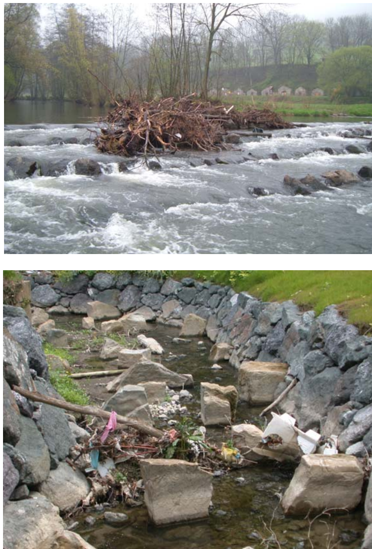
Figure 28 : Exemple d'embâcles au sein de dispositifs.
