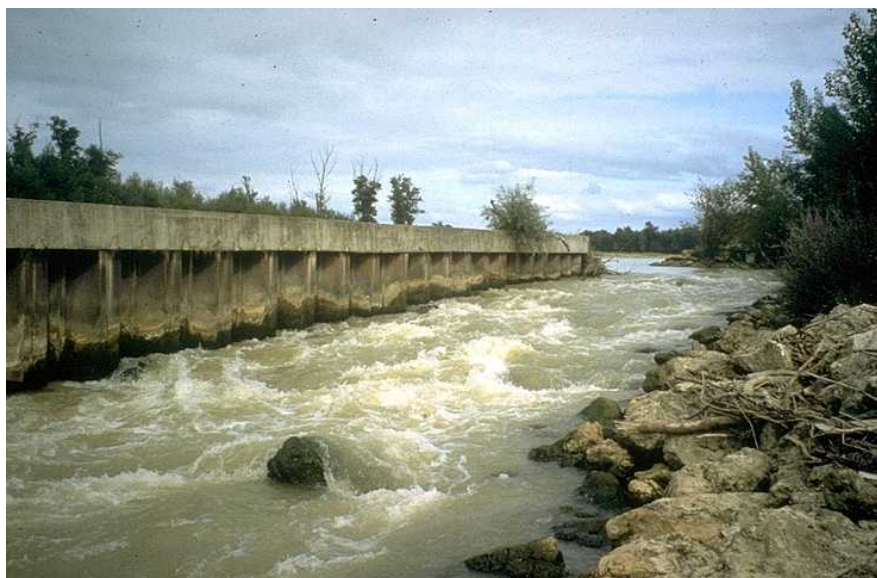
Figure 19 : Rampe en enrochements jointifs au seuil de Toulouzette
