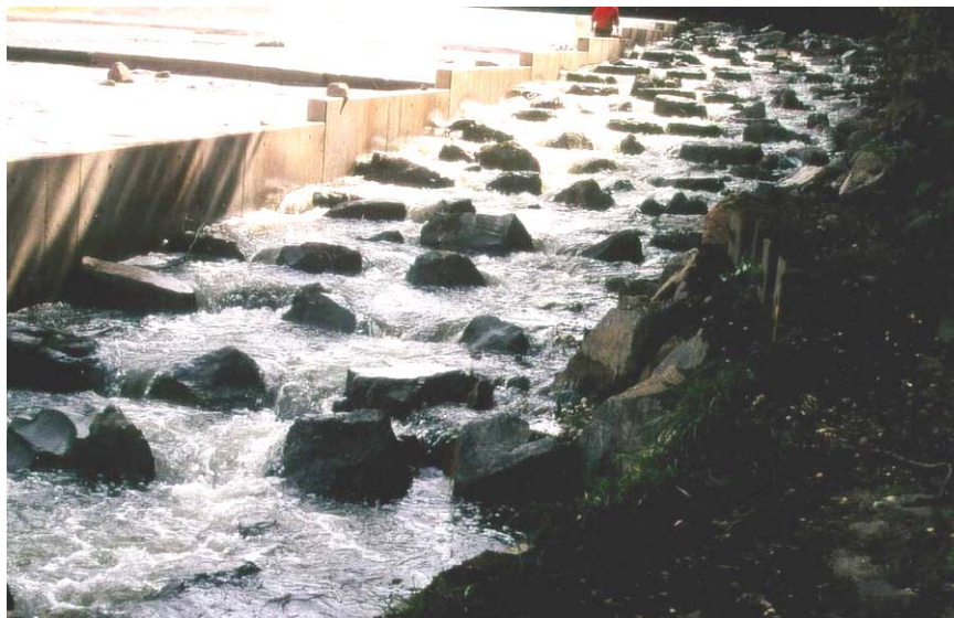
Figure 7 : Ecoulement au travers d'enrochements en rangées périodiques
