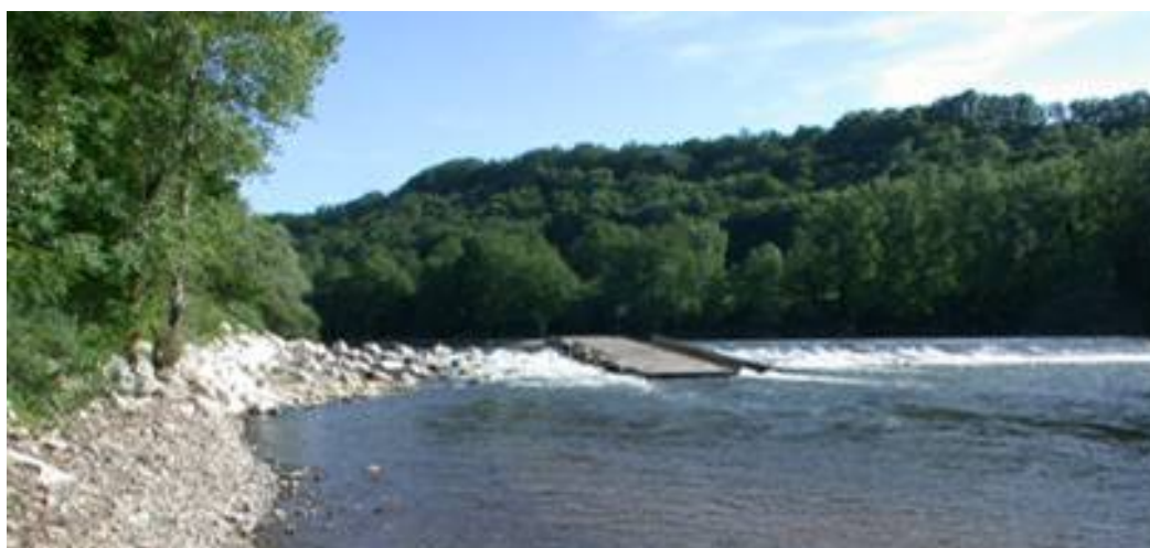
Figure 16 : Rampe en enrochements de Carennac (Dordogne)
